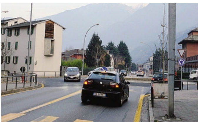
La nuova rotonda che è stata completata a Morbegno
